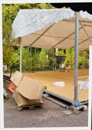
Unser neues Zelt mit 180qm ist auf der Freifläche aufgebaut,...
